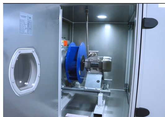
Figure 16. Plug Fan Section
